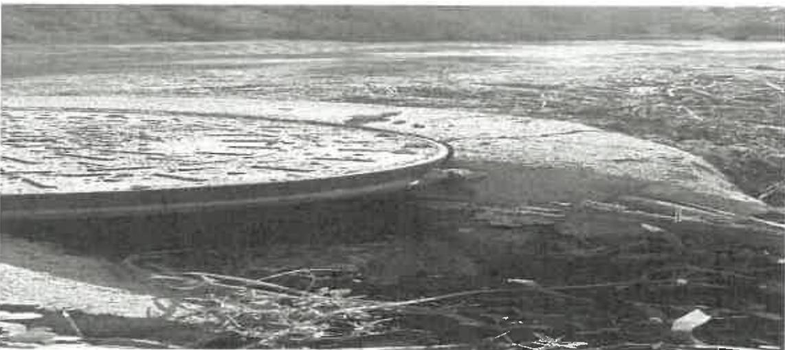
Fotos 2 e 3 - Penúltima caixa, alteada com aro em betão de cimento simples, incompleto, para permitir saída dos esgotos. Nota-se o nível dos esgotos dentro da caixa e a escorrência para a valeta (2021/08/11)
